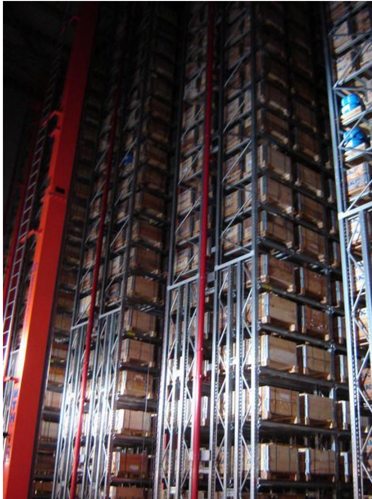
Foto 4: sprinklerinstallatie (rode brandwaterleiding)
