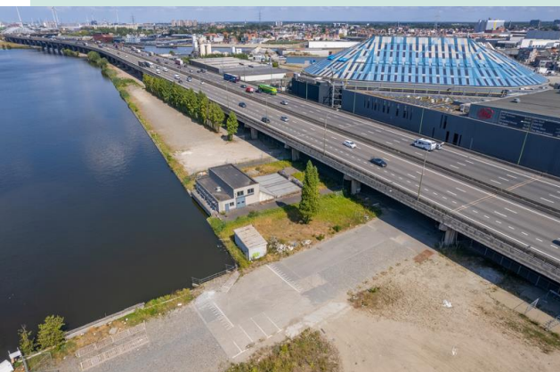
Waterzuiverings- installaties Merksem & Deurne
