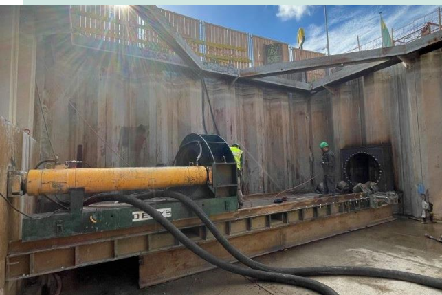
Kabels en leidingen
