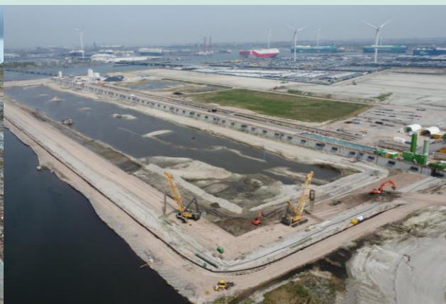
Diepe wanden maken bouwput waterdicht
