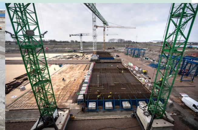
Start bouw eerste tunneldeel
