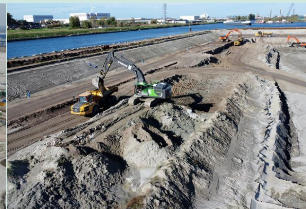
Uitgraven eerste deel bouwdoek
