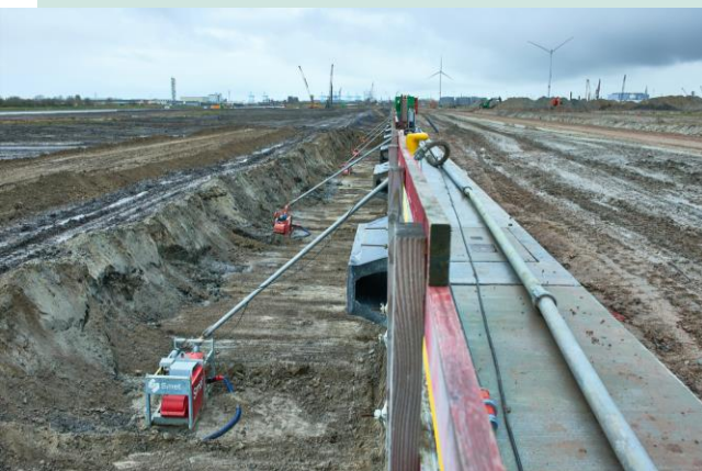
Bouw kademuur en terrein werfklaar
